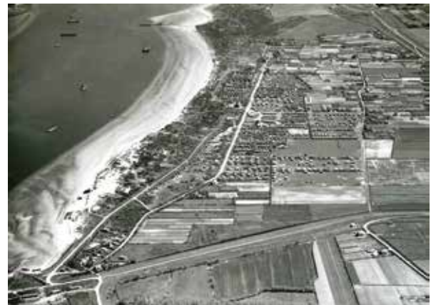
Luchtfoto van het Kruiningergors uit 1950. Op deze luchtfoto is de eerder genoemde bestorting met betonblokken goed te zien (linksonder). Ook is goed te zien over welk kleine stukje dijk er al die jaren in de Provinciale Staten is gepraat
