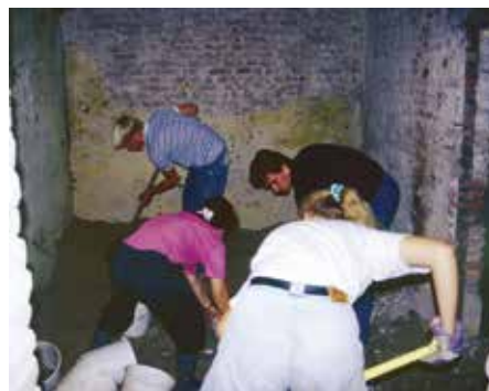
Leegscheppen van de bunker. Foto: Jan Alewijn Dijkhuizen
