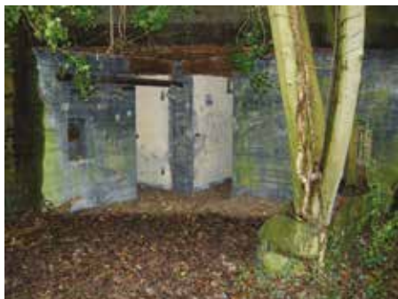
Bunker bij particulier. Foto: Jan Alewijn Dijkhuizen
