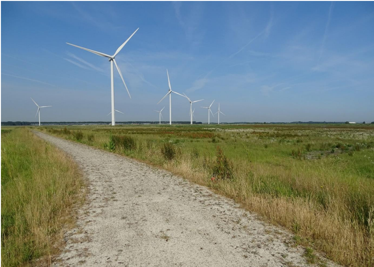
17-06-2023 Zicht vanaf het oostelijk fietspad op de vijf windturbines
